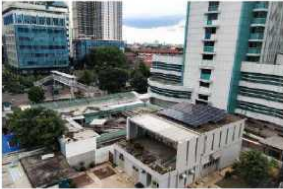
PLTS Gedung Utiliti (15 KWp)
