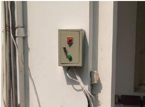
Panel Otomatis untuk kran siram taman di Taman FKUI (depan Departemen Frmasi)
