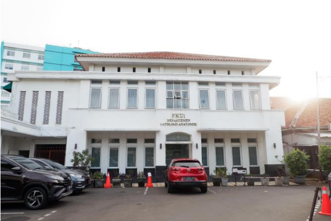
Gedung Patologi Anatomi (LB=2,118.36 m2)
