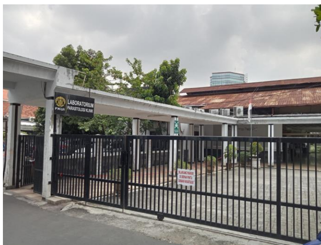
Gedung Parasitologi (LB = 3.861,36 m2)
