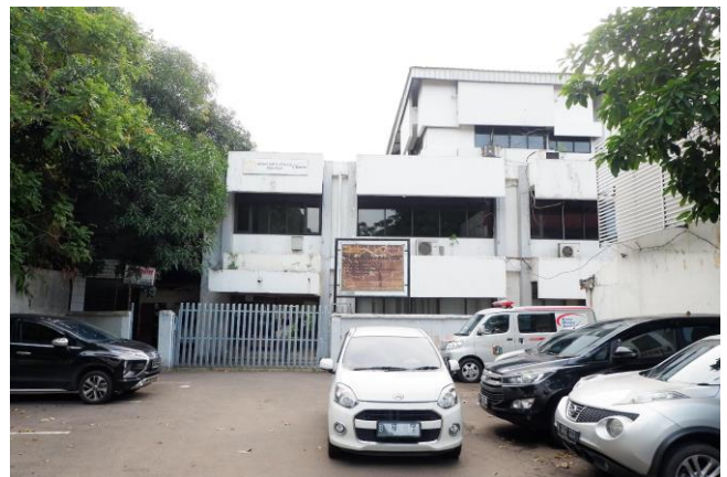
Gedung Ilmu Gizi ( LB=895.9 m2)
